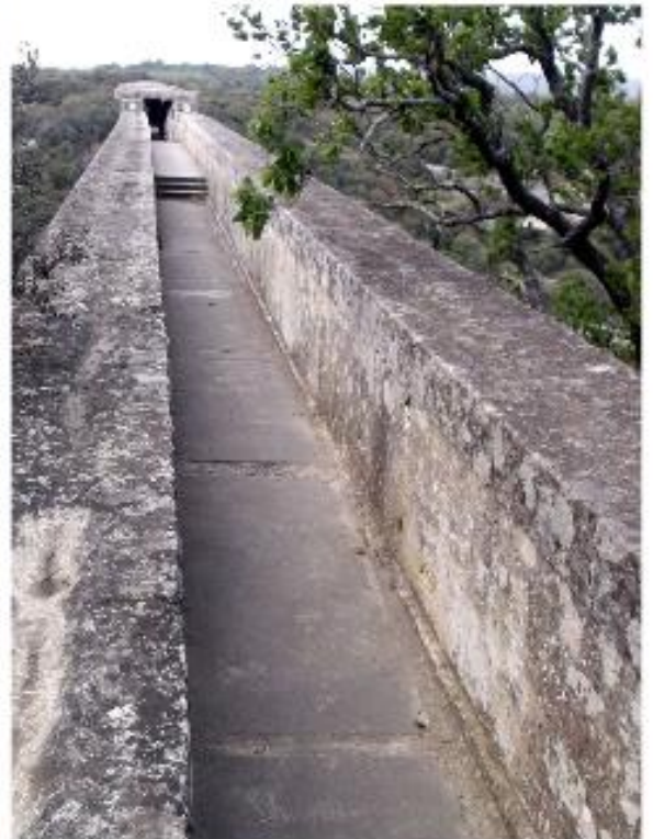
Vue de la couverture du canal
